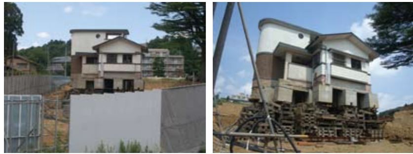
向かいの高台・仮囲い隙間から撮影した現状写真
