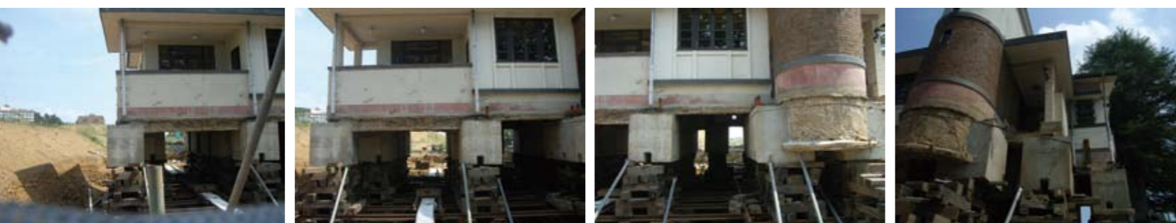
仮囲い隙間からフーチングのすき間を探して撮影した写真
